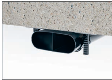
Canale piatto sul tetto della cantina
